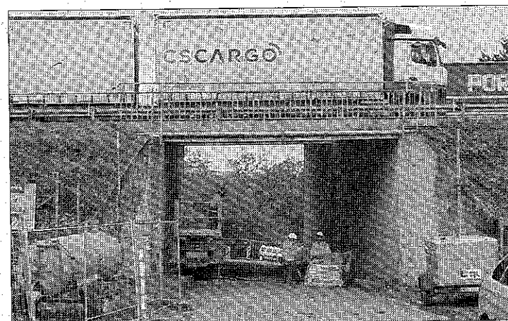
Renforcement de la sous face du tablier du pont. Photo ER
